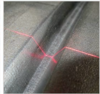
파이프의 V자형 갭 측정
